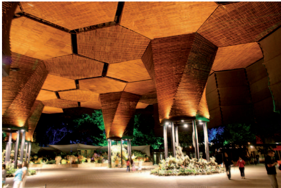
plan:b arquitectos eta jprcr arquitectos-ek Medellinen eraikitako Orquideorama. Egituraren oinarria hexagonoa da. Irudia: ATOM Arquitectura, Flickr
